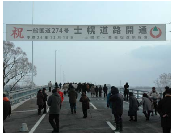
完成し、渡り初めを迎えた土幌大橋
